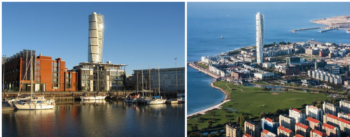
شکل ۹. ترینگ تروسو یا برج پیچنده در شهر مالمو
